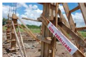
Obra interrompida em Córrego das Chuvas
